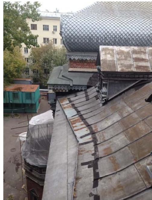
((Datei: 1238183_450781395040936_257719214_n)) Die ursprüngliche Dachgestaltung bildete die Grundlage für die Restaurierung.
