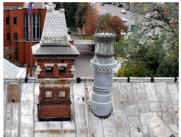
((Datei: 10259071_566214476830960_4165479109003713_693_o.jpg)) Die vorhandene historische Zinkdeckung musste bei der Sanierung erhalten bleiben und ergänzt werden.
