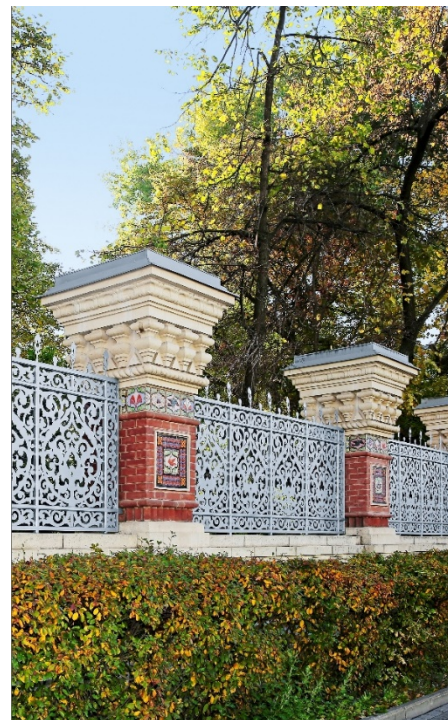
((Datei: 2370-005_A4_RET)) Zum Auftrag gehörten auch die Abdeckungen der Kronen der Zaunpfeiler sowie die Zaunelemente.
