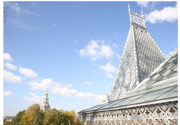
((Datei: C02B5968)) Details wie die reich verzierten Dachüberhänge wurden originalgetreu mit Zierleisten nachgebildet.
