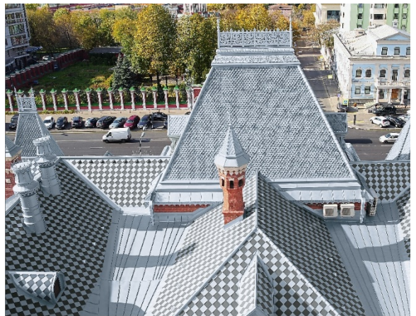
((Datei: 2370-002_A4_RET_Foto RHEINZINK)) Die Walmdächer sind mit quadratischen und spitzen, biberschwanzförmigen und zum stilisierten Kreuz geformten Sonderrauten gedeckt, die Satteldächer mit Doppelstehfalzprofilen.
