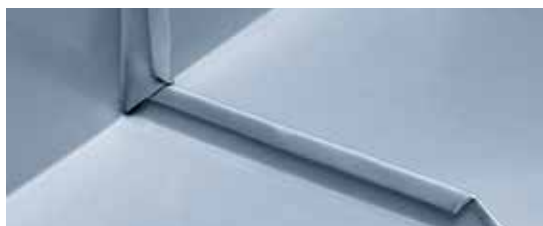
Quetschfalz an Dachdurchbruch (2) Brustbereich
