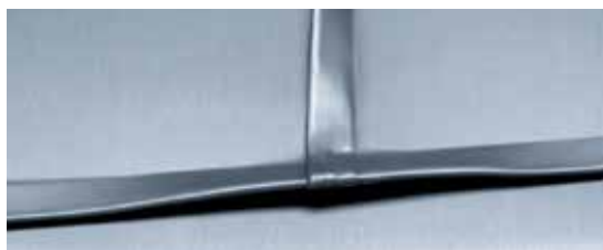
Knotenpunkt (4) Schar an Querfalz, Nackenbereich
