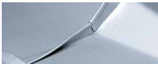
Doppelter Quetschfalz in Querfalz (3) Nackenbereich
