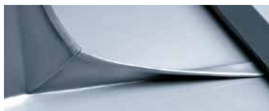
Runder Falzanschluss (1b) Höhe \geq 150 mm mit Wasserfalz in Dehnungsleiste
