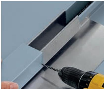
Skizze 29: Herstellung der Bohrung für den Niet
