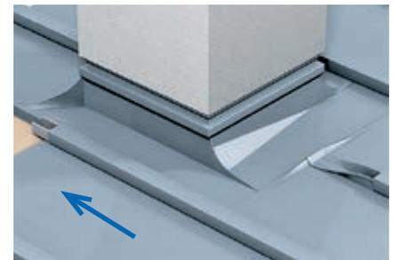
Skizze 66: Anschluss an Kamin im Nackenbereich mit Gefällekeil und Stehfalzadapter
